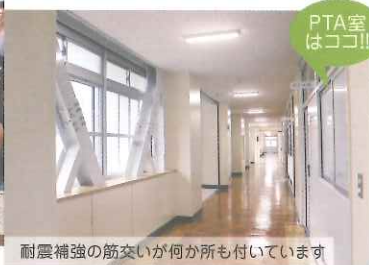
耐震補強の筋交いが何か所も付いています
